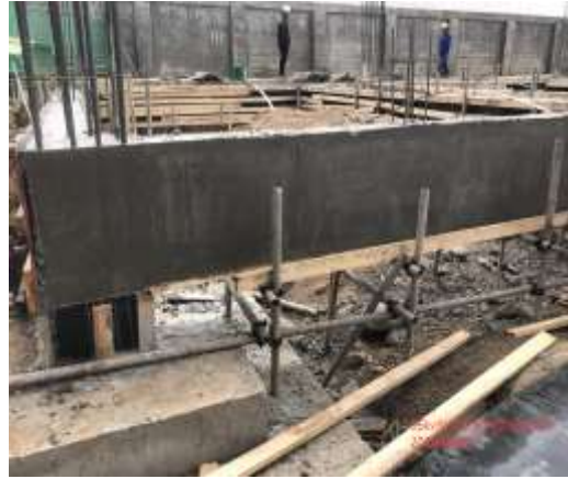
升压站扩建工程基础浇筑（拆模）
