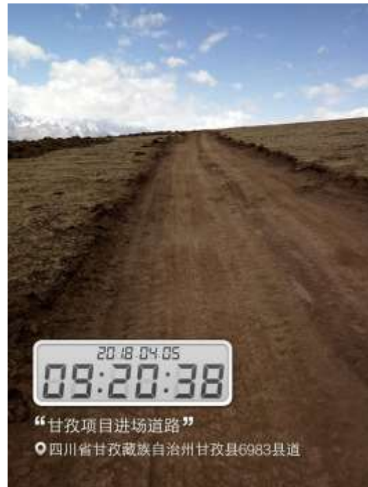
进场道路施工
