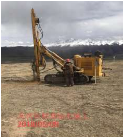
光伏支架基础钻孔
