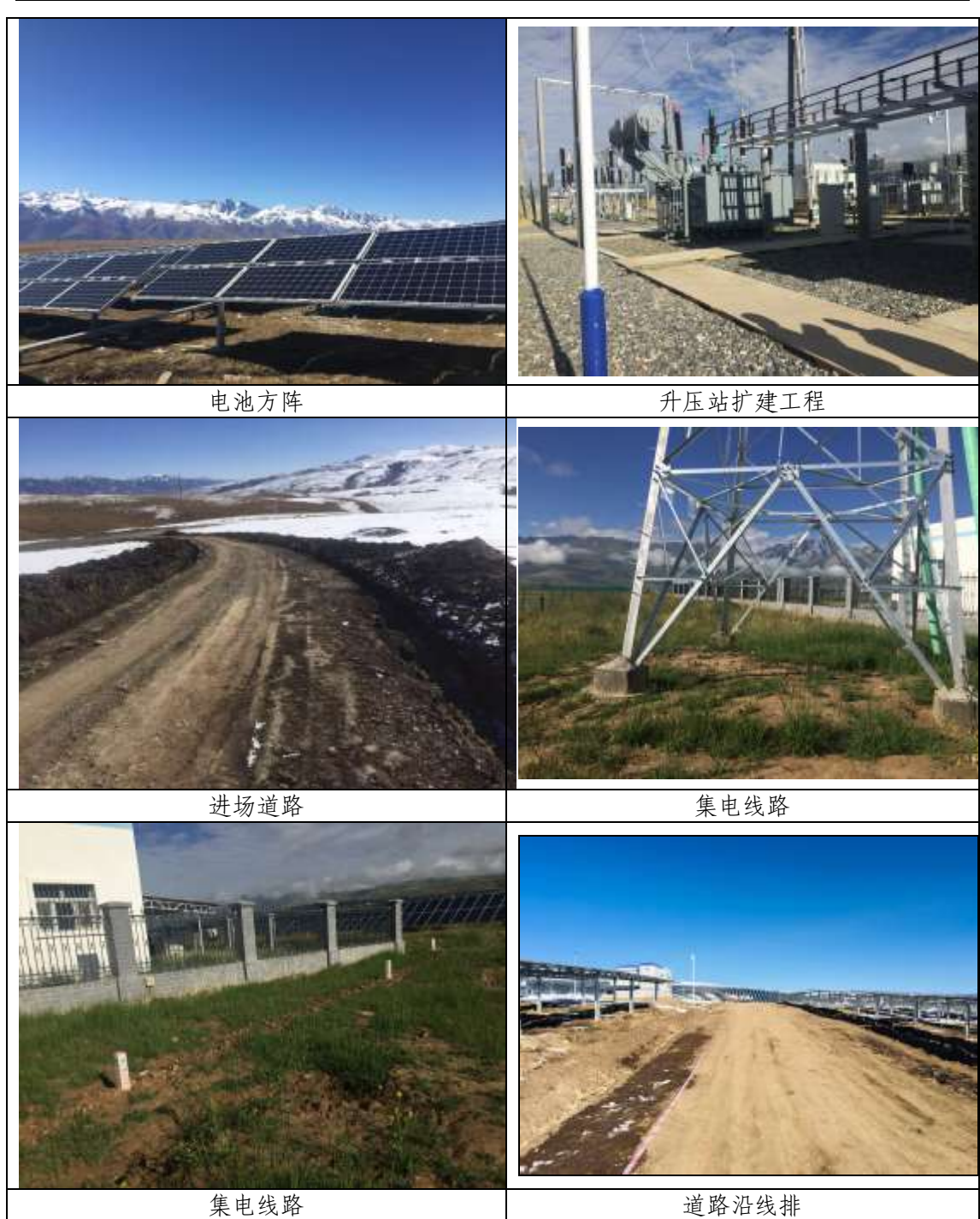
图 2 项目现场情况
