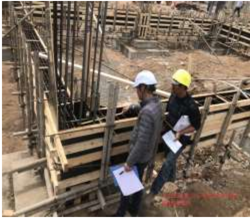
升压站扩建工程基础施工
