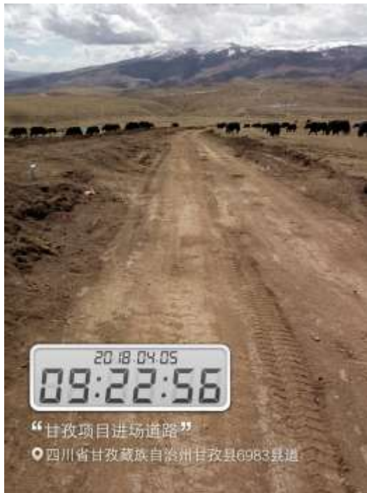
进场道路施工
