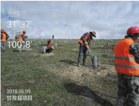
光伏支架基础浇筑
