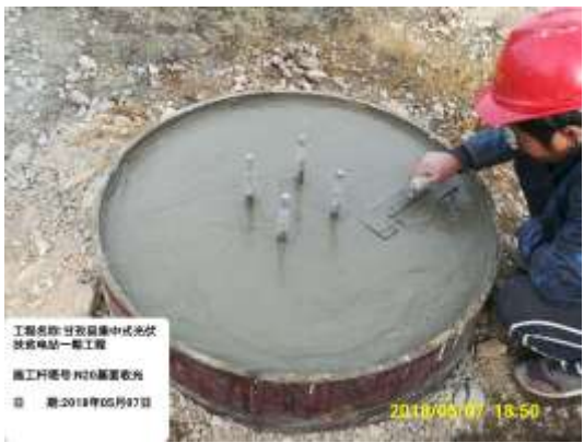
塔基基础浇筑完成及周边扰动范围
