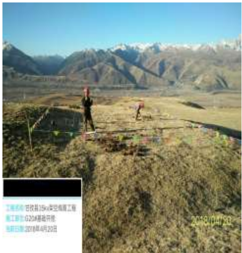
塔基施工扰动范围
