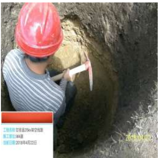
塔基基础人工掏挖
