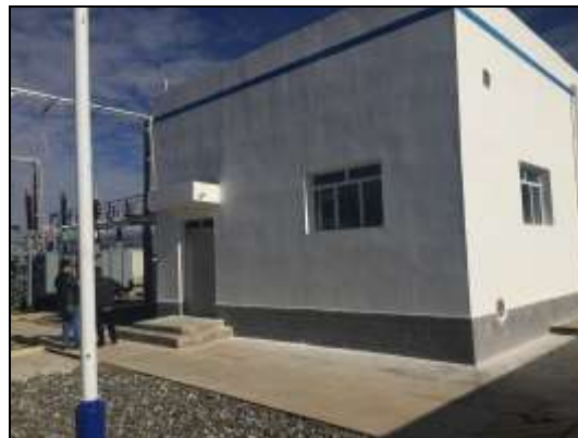
图 3.27 配电楼及二次设备室
