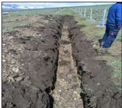
图 3.9 直埋线路施工（一）
