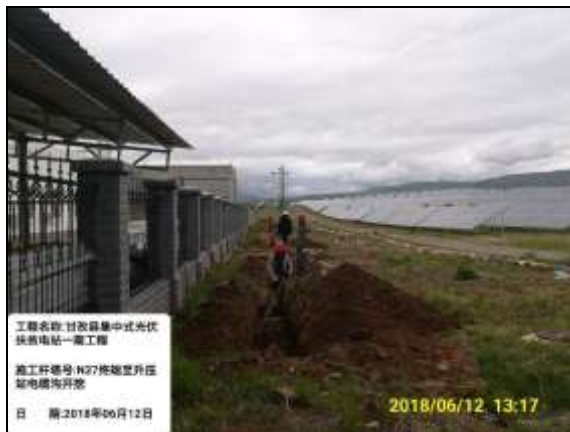
图 3.10 直埋线路施工（二）
