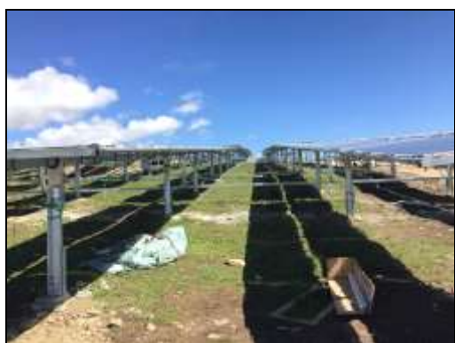
图 3.20 光伏区植被恢复 (18 年 8 月摄)
