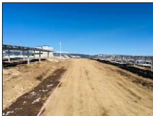
图 3.31 场内道路整改后现状（11月）
