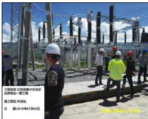
图 3.6 升压站扩建工程初验
