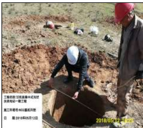
图 3.13 塔基基础掏挖施工（三）
