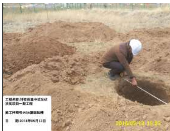
图 3.14 塔基基础掏挖施工（四）
