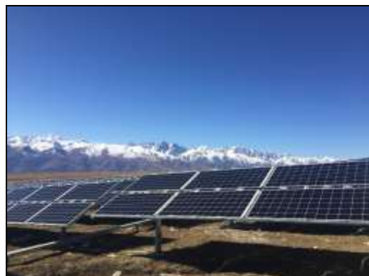
图 3.21 光伏区植被恢复 (18 年 10 月摄)
