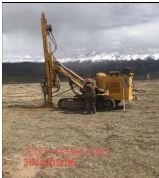
图 3.1 桩基钻孔施工
