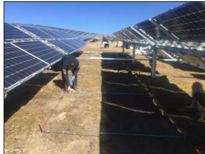
图 3.23 光伏区植被调查（18年10月摄）
