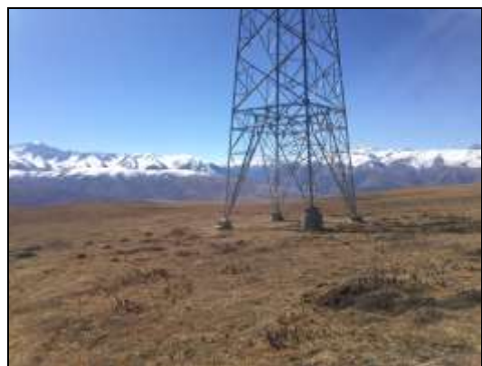
图 3.40 光伏区终端塔 (18 年 10 月摄)
