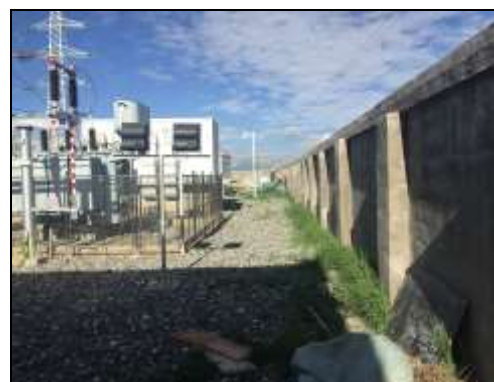
图 3.29 此次扩建扰动范围控制围墙内
