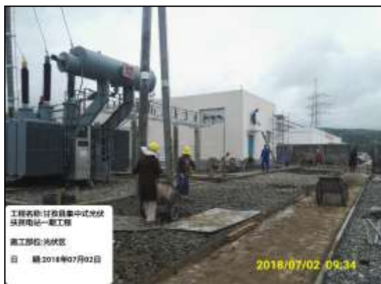
图 3.5 升压站铺石子施工
