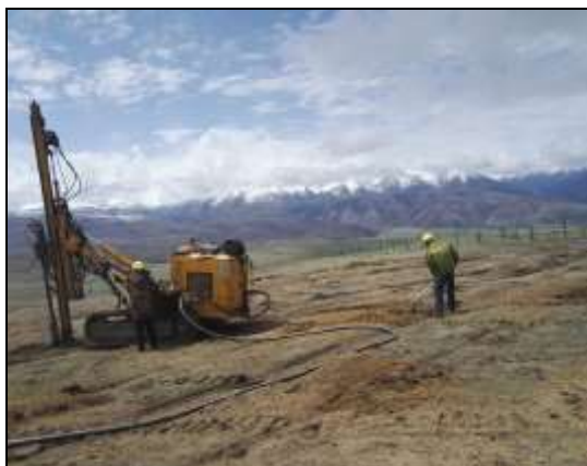
图 3.3 桩基钻孔施工
