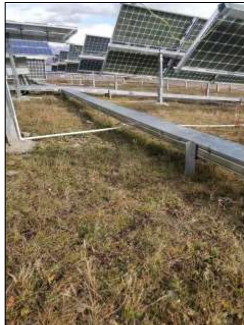
图 3.17 光伏区植被恢复 (18 年 10 月摄)
