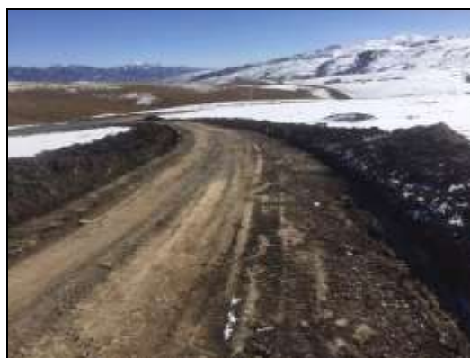
图 3.33 进场道路整改后现状（11月）
