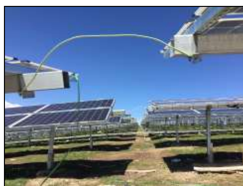
图 3.19 光伏区植被恢复 (18 年 8 月摄)
