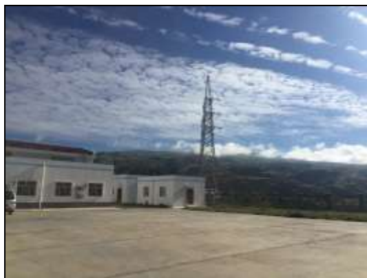
图 3.38 升压站终端塔 (18 年 8 月摄)
