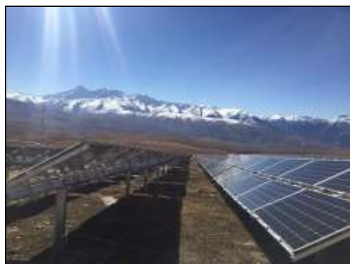
图 3.18 光伏区植被恢复 (18 年 8 月摄)
