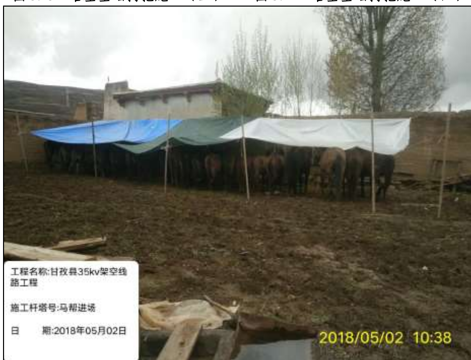
图 3.15 35kV 架空线线路材料运输（马帮进场）
