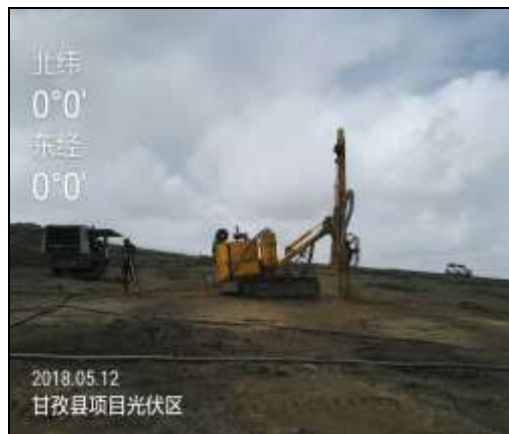
图 3.4 桩基钻孔施工
