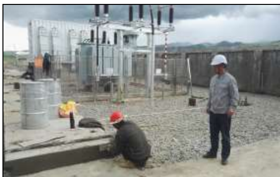
图 3.24 构筑物周围碎石铺筑
