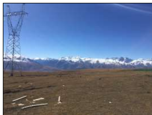
图 3.41 线路中间塔植被恢复 (18 年 10 月摄)
