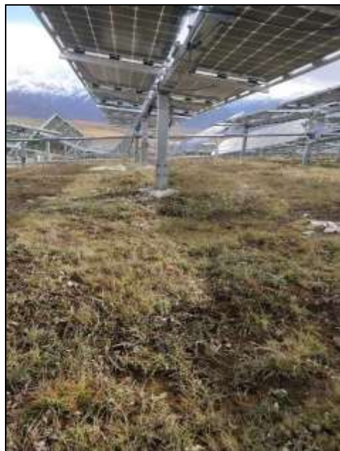
图 3.16 光伏区植被恢复 (18 年 10 月摄)
