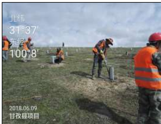
图 3.2 支架桩基础混凝土浇筑
