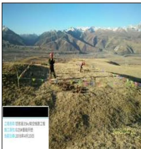
图 3.11 塔基基础掏挖施工（一）
