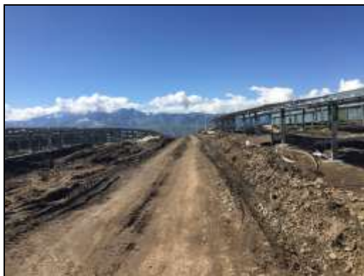
图 3.30 场内道路整改前情况（8月）
